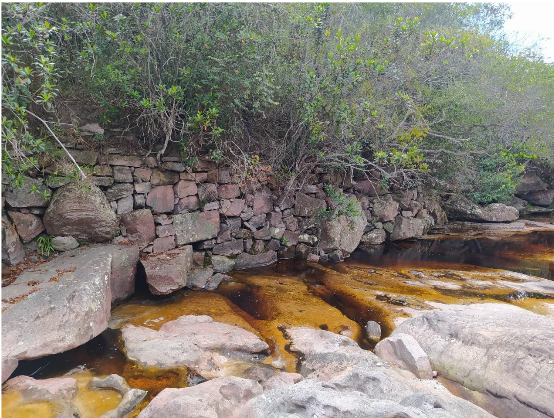
Fig. 52 – Muro construído na margem do Córrego dos Pombos.
