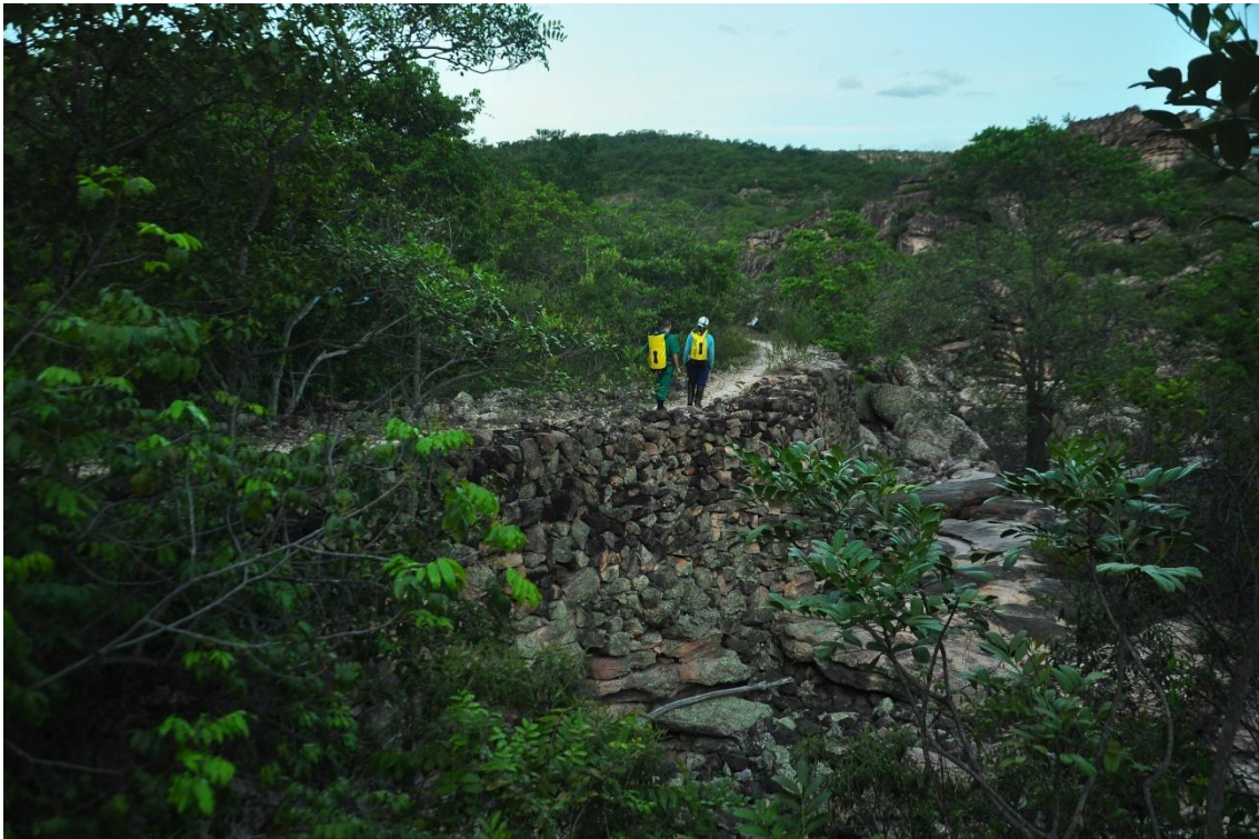
Fig. 39 – Construção do período do garimpo constituído por grandes blocos de rocha, sobre os quais passa a “Estrada do Garimpo”, um antigo acesso para a Vila de Igatu.
