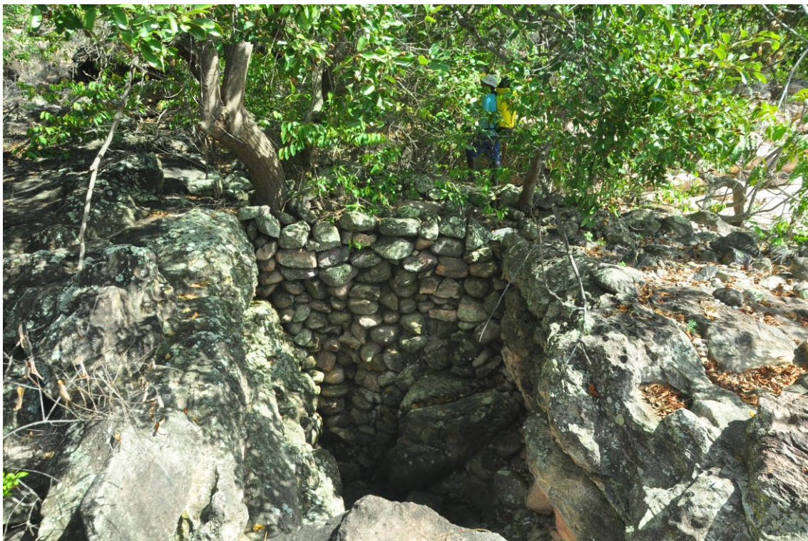
Fig. 40 – Preenchimento e cobertura de fendas para passagem de estrada, construção comum na área de estudo.
